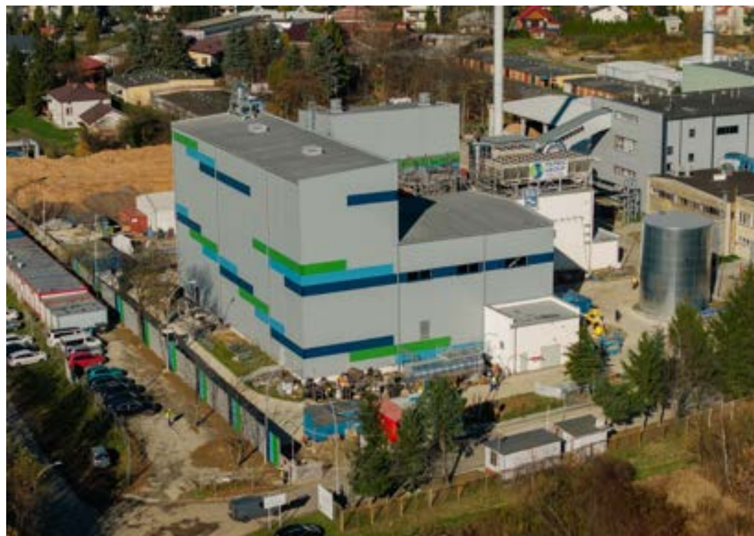
Budowa bloku energetycznego. Fot. Krośnieński Holding Komunalny
