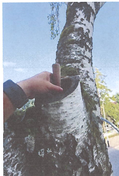
fot.12 Ubytek w rozwidleniu II rzędu na przewodniku centralnym
